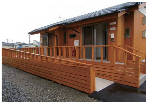
図1 熊本豪雨災害時に建設された木造仮設住宅
