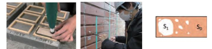
図1 タイル張付け様子 図2 構造壁による周波数測定 図3 浮き印象図
